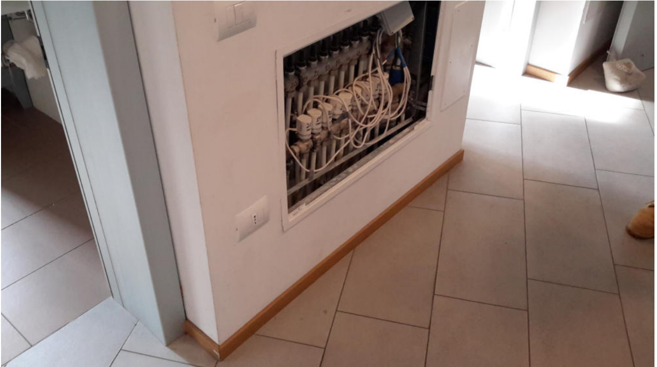
Collettore Impianto Radiante a Pavimento
